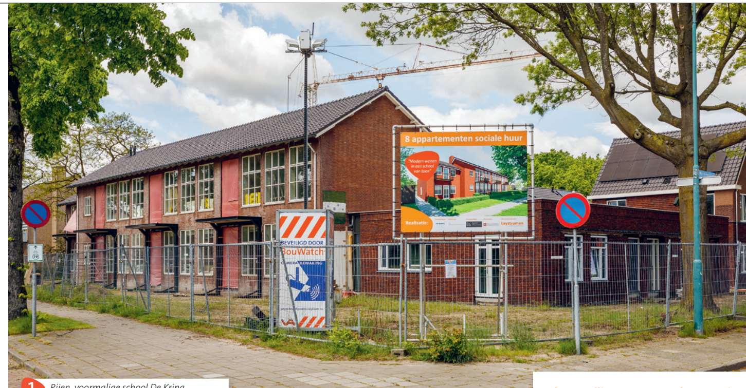
1 Rijen, voormalige school De Kring
