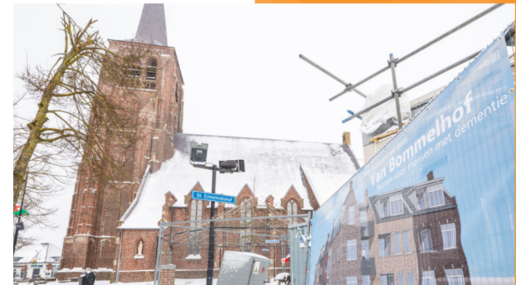
De bouw in het centrum van Moergestel is gestart.
