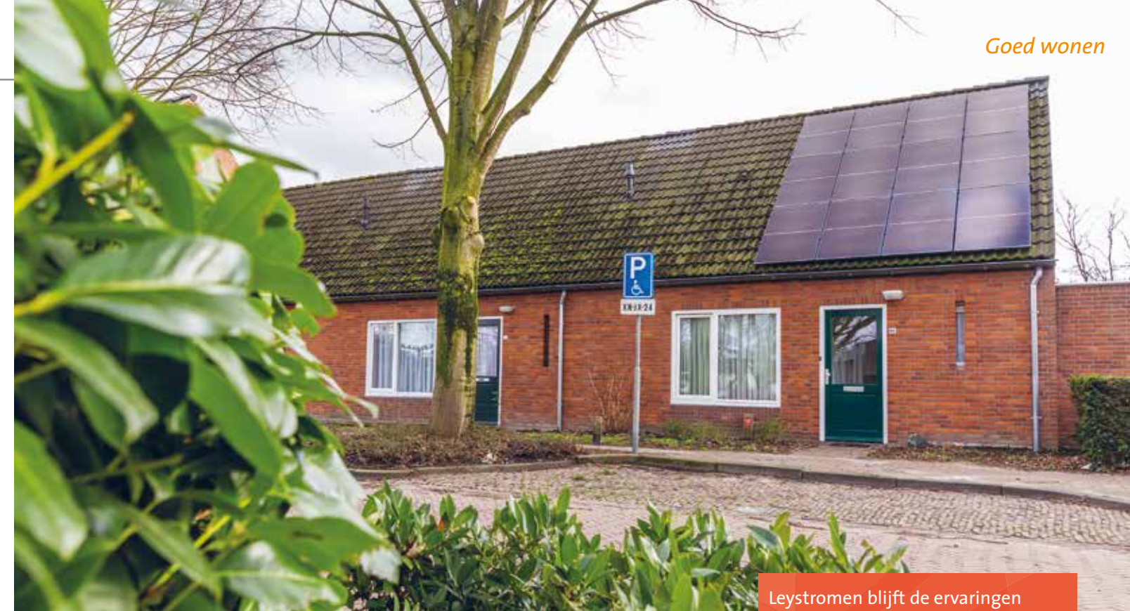
De eerste CO 2 -neutrale woning van Leystromen die verwarmd wordt met infraroodpanelen.
